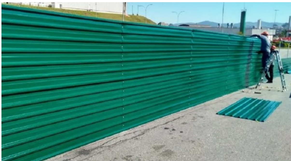
Modelo de tapume em chapa metálica.
